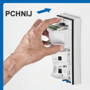
Umieszczanie głównego modułu
