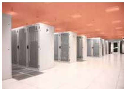
Zabezpieczenie sufitu w serwerowni
