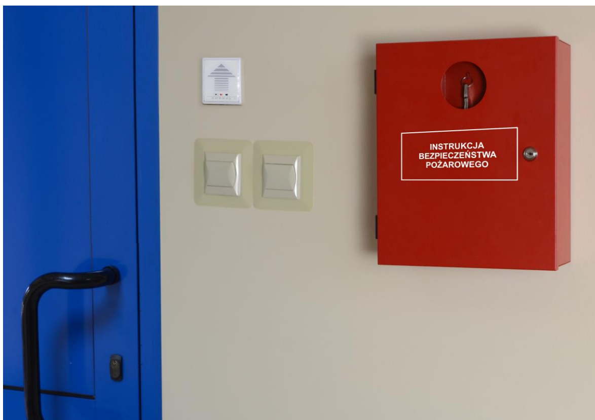
Rys.2. Przykładowy montaż szafki na instrukcję bezpieczeństwa pożarowego.
