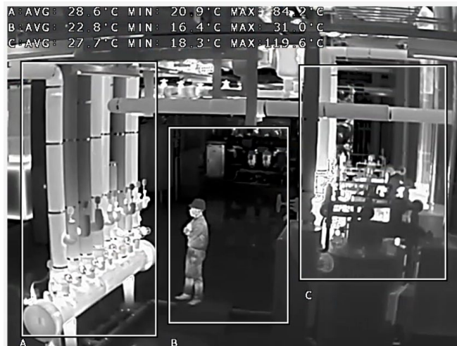
[Rysunek 17. Przykład średniej, maksymalnej i minimalnej temperatury w zależności od obszarów ROI]
